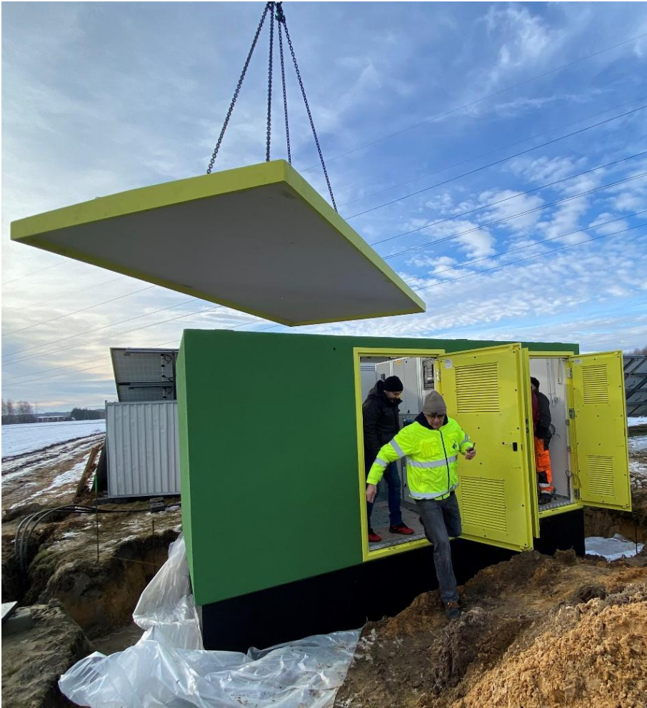
Zdjęcie 11 Montaż stacji transformatorowej
