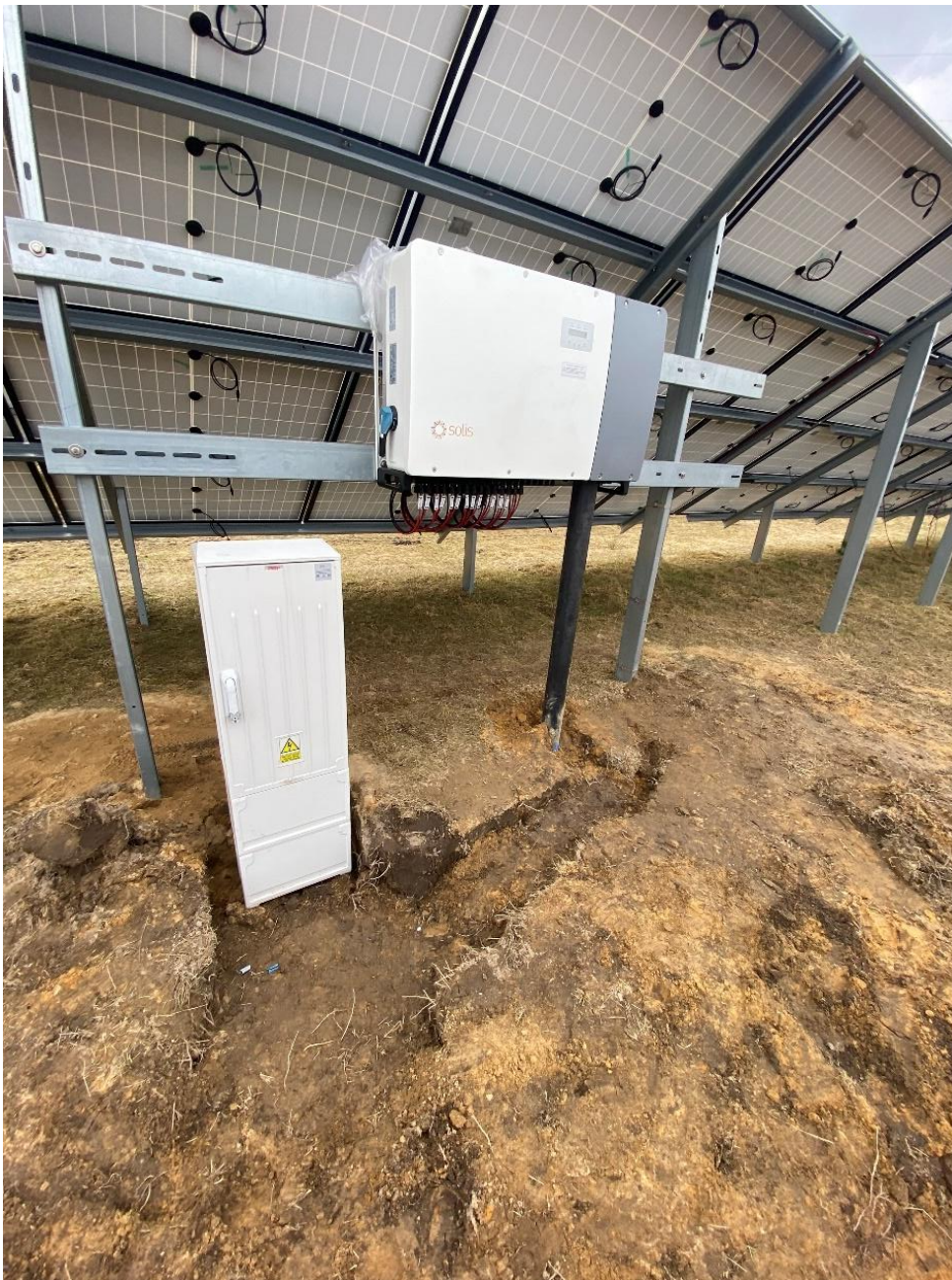
Zdjęcie 10 Przykładowy montaż inwertea
