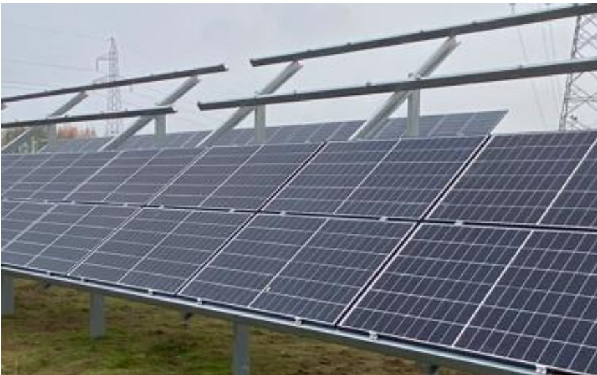
Zdjęcie 9 Moduły fotowoltaiczne montowane na konstrukcji wsporczej
