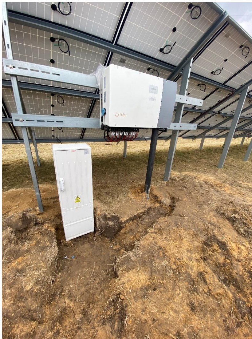
Zdjęcie 3 Przykładowy montaż inwertera
