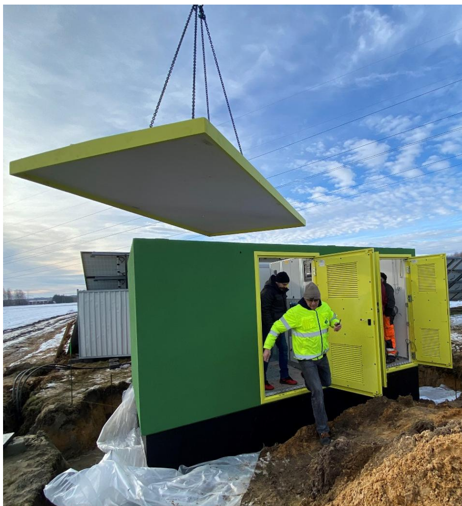
Zdjęcie 10 Montaż stacji transformatorowej
