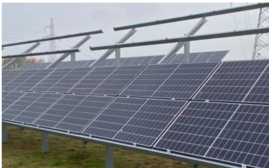
Zdjęcie 8 Moduły fotowoltaiczne montowane na konstrukcji wsporczej
