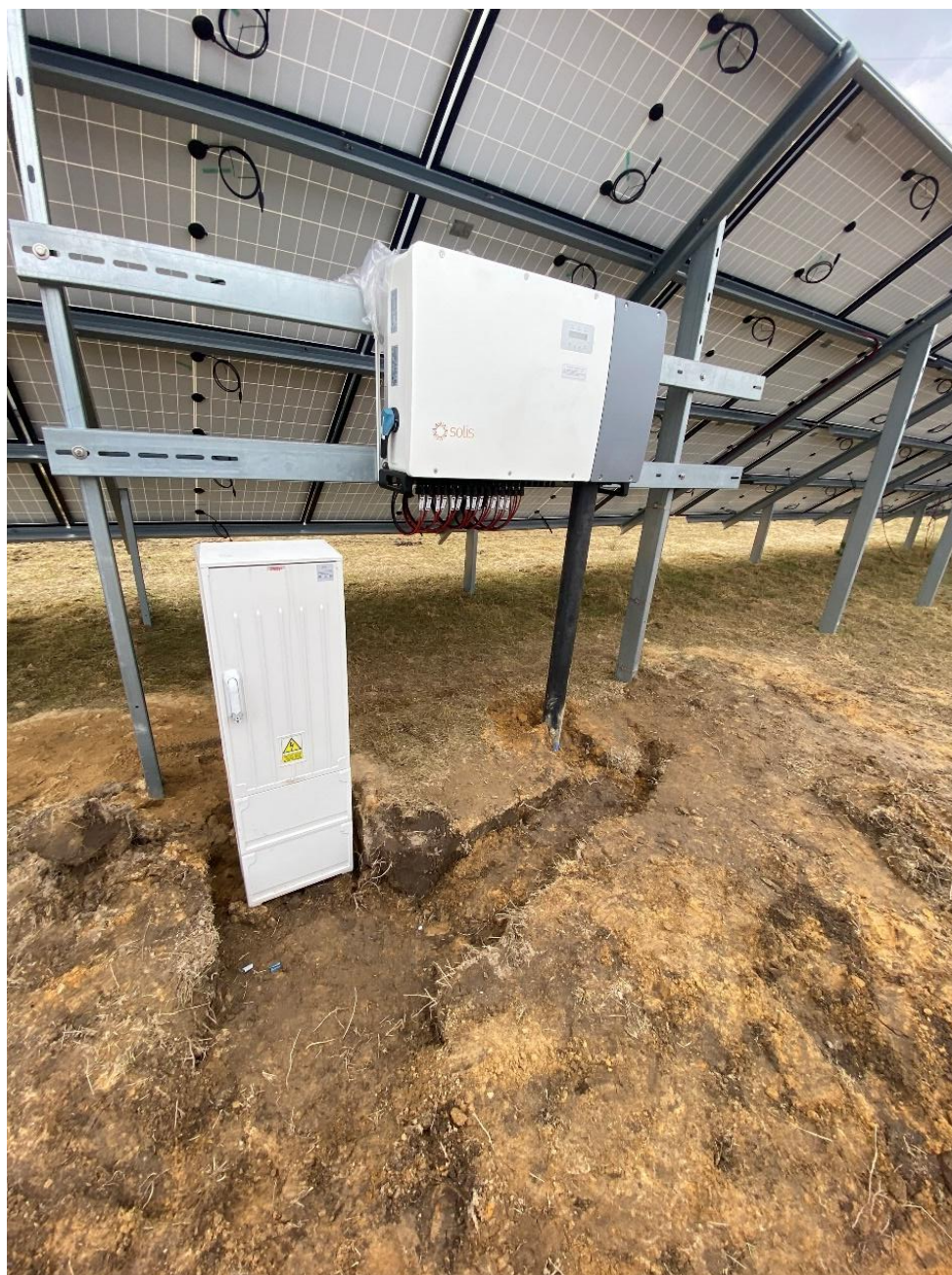
Zdjęcie 9 Przykładowy montaż inwertera
