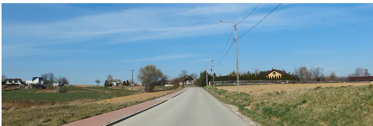
Fot. 1 Widok z drogi gminnej nr 362024T - odcinek na zachód od drogi wojewódzkiej Nr 756
